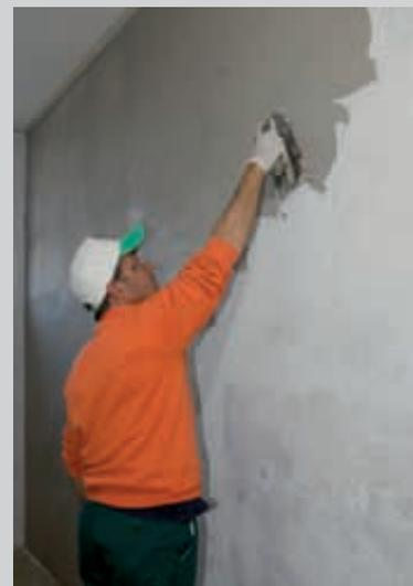
Questi possono essere applicati direttamente, con la possibilità di realizzare alti rivestimenti (fino a 2 cm di spessore) oppure rasature, ad esempio utilizzando **NAI CM RASANTE ULTRA**.
