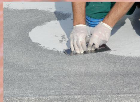
3) Miscelazione, mediante miscelatore elettrico dei tre componenti di Ceramic 1° mano (vd scheda tecnica). Applicazione della 1° mano mediante spatola liscia di acciaio, rasando a zero, sui verticali e sull'intera superficie.
