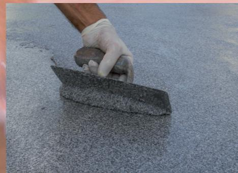
4) Entro le 24 ore, ad asciugatura del prodotto, applicazione di Ceramic 2° mano sui verticali e sulla superficie orizzontale.
