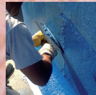
3) Applicazione del Ceramic Pool Base, con spatola liscia di acciaio, avendo cura di rasare a zero sui verticali e sull'intera superficie.
