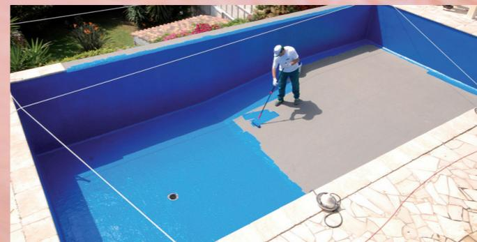
1) Applicazione a rullo o pennello della 1° mano di Ceramic Pool Primer sui verticali e sulla superficie orizzontale.
