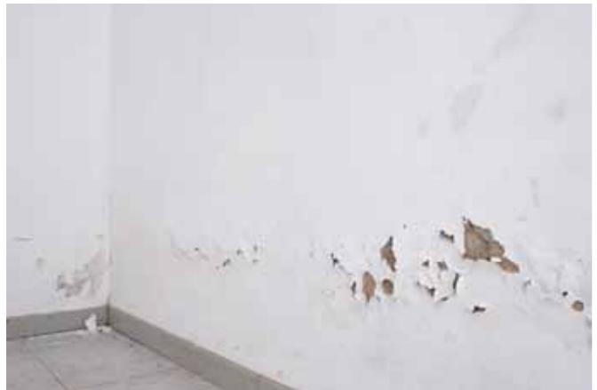
Il degrado si manifesta con efflorescenze saline e muffe che finiscono per danneggiare completamente malte ed intonaci.
