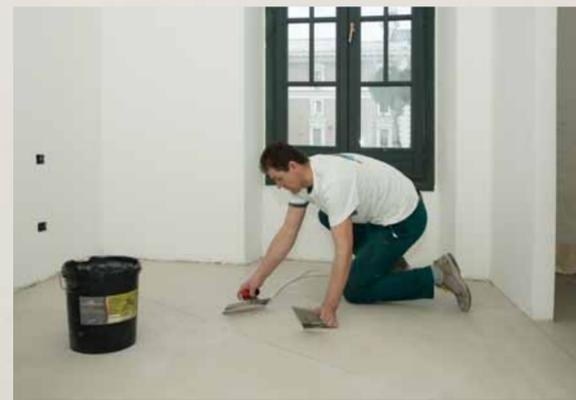
Applicazione della seconda mano di DECORESINA FLOOR
