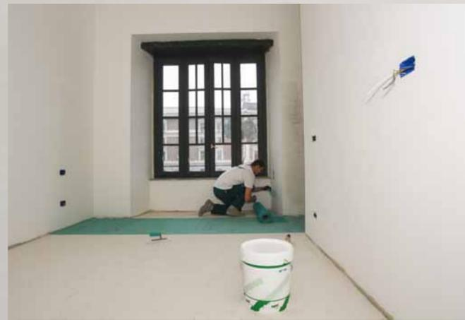
Pavimento prima dell'intervento ed armatura del supporto con rete di vetro fv 170
