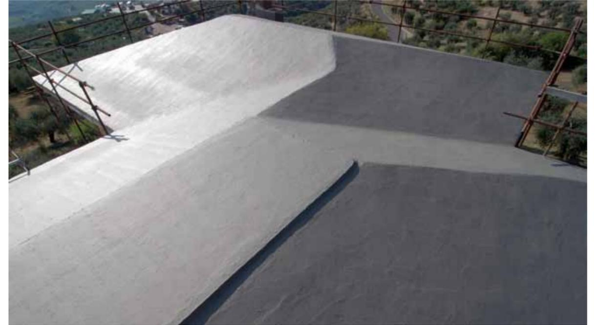
Impermeabilizzazione di un tetto a falde mediante l'utilizzo di Guaina+ Naici.
