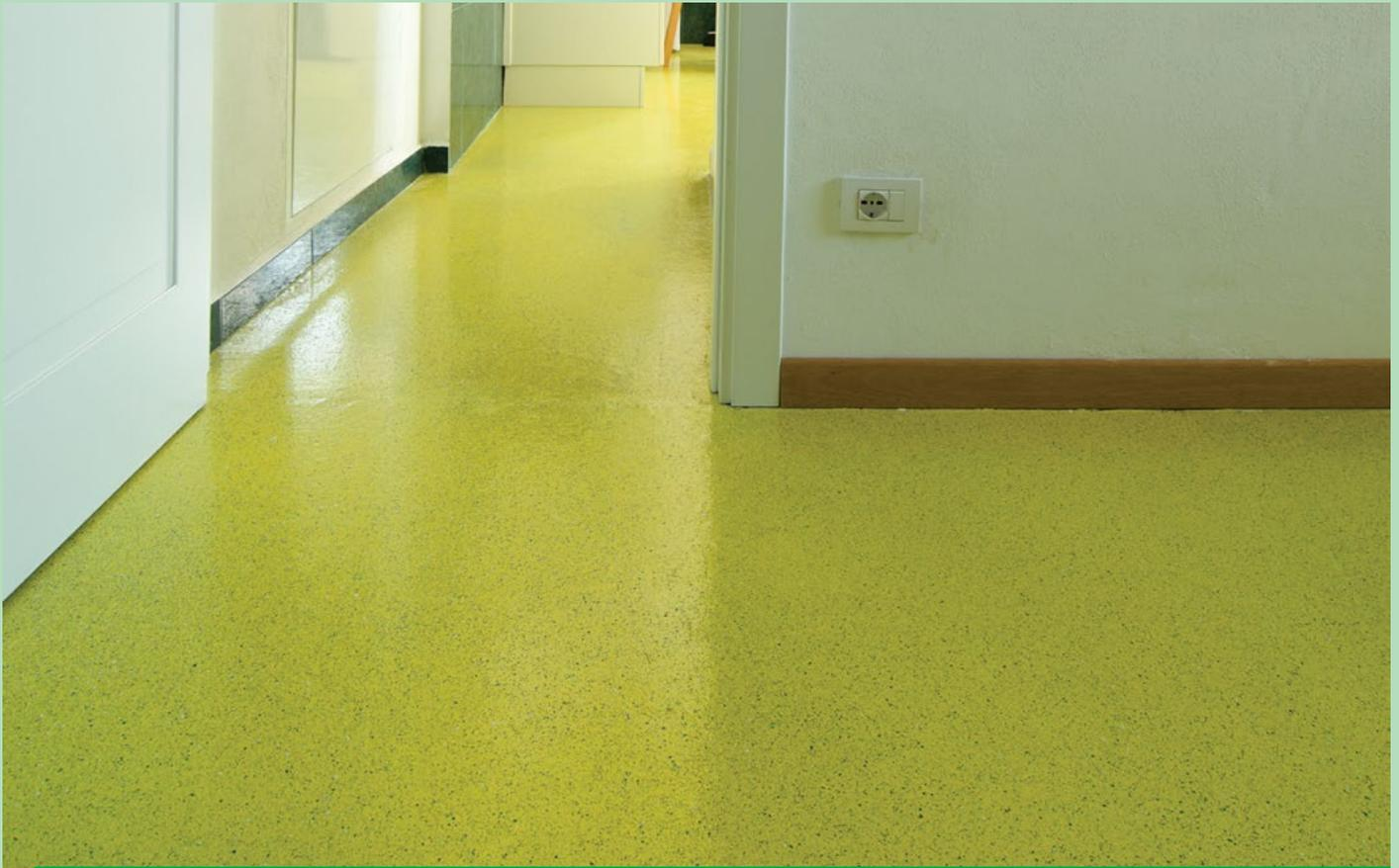
Pavimento in resina realizzato mediante sistema di applicazione "L'Altro Granito".
