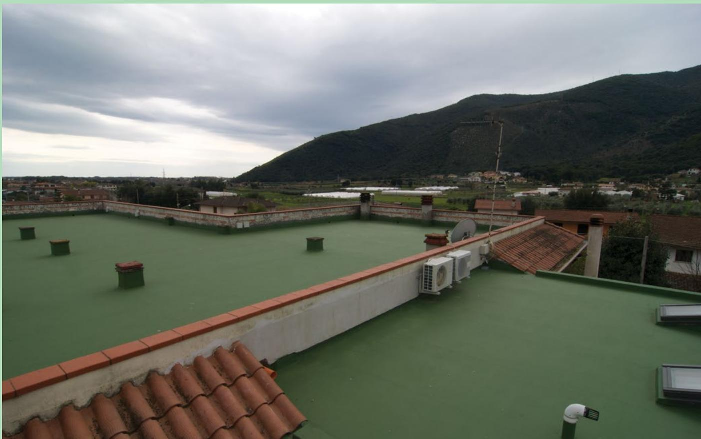
Impermeabilizzazione realizzata mediante guaina liquida bicomponente cementizia “Cemenguaina” (colore verde).
