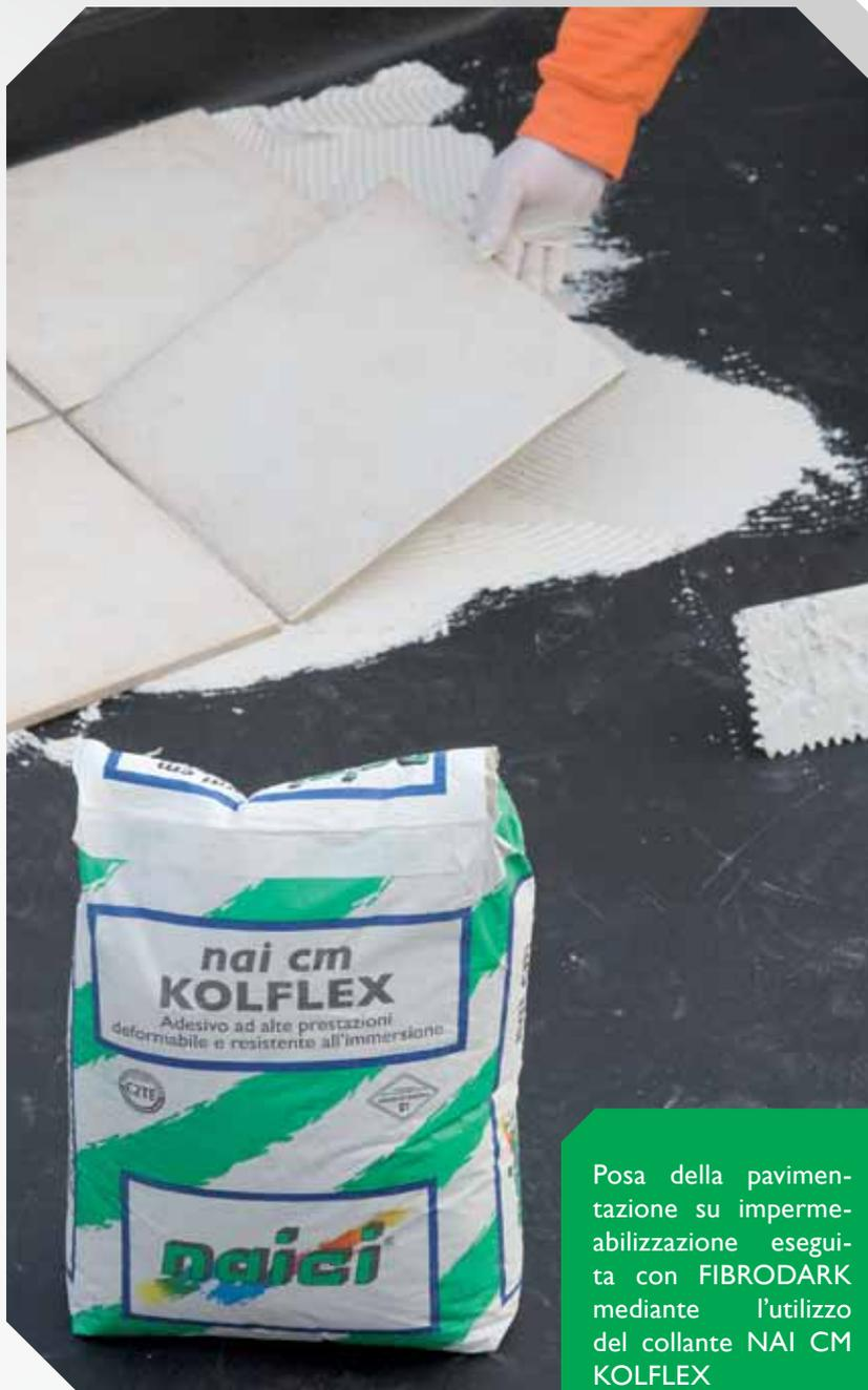
Posa della pavimentazione su impermeabilizzazione eseguita con FIBRODARK mediante l'utilizzo del collante NAI CM KOLFLEX
