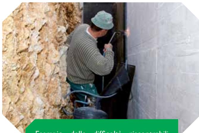
Esempio delle difficoltà riscontrabili nell’impermeabilizzare tramite le vecchie guaine a rotoli
