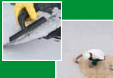
**FIBROGUAINA (a rullo) & FIBROGUAINA-S (a spatola):** Guaina liquida monocomponente antiristagno di facile applicazione, su qualsiasi superficie, per l'impermeabilizzazione definitiva di balconi, terrazzi, coperture e docce.
