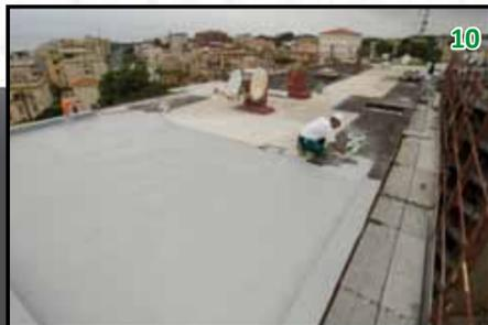
• O in alternativa si può applicare la Fibroguaina-s mediante l'uso della spatola (fig. 9 e 10)
