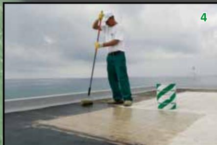
• Si inizia l'impermeabilizzazione applicando sui verticali e sulla superficie il primer ancorante NAI 45. (Fig. 3 e 4)
