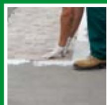
CEMENGUAINA, leader tra i prodotti impermeabilizzanti è una guaina liquida bicomponente da miscelare al momento dell'uso. Disponibile in diverse colorazioni è applicabile effettivamente a rullo, su superficie asciutta o umida. Opportunamente armata, permette di impermeabilizzare, con soli due millimetri di spessore, qualsiasi spazio di abitazioni ed immobili in genere.
