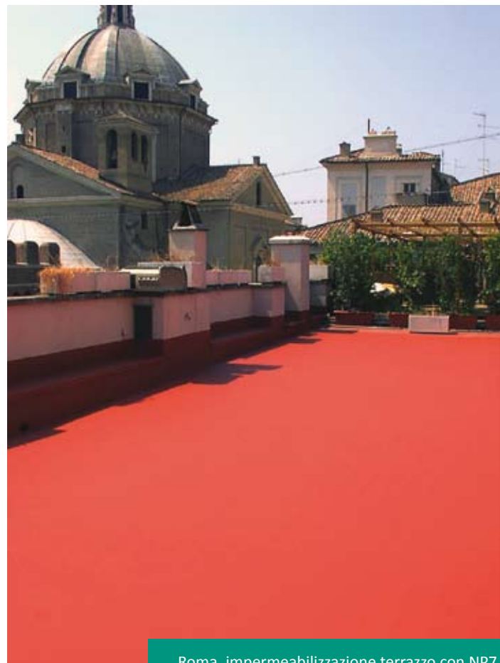
Roma, impermeabilizzazione terrazzo con NP7
