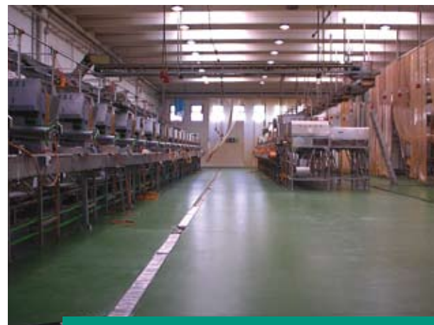
Priverno (LT), ripristino pavimentazione industriale
