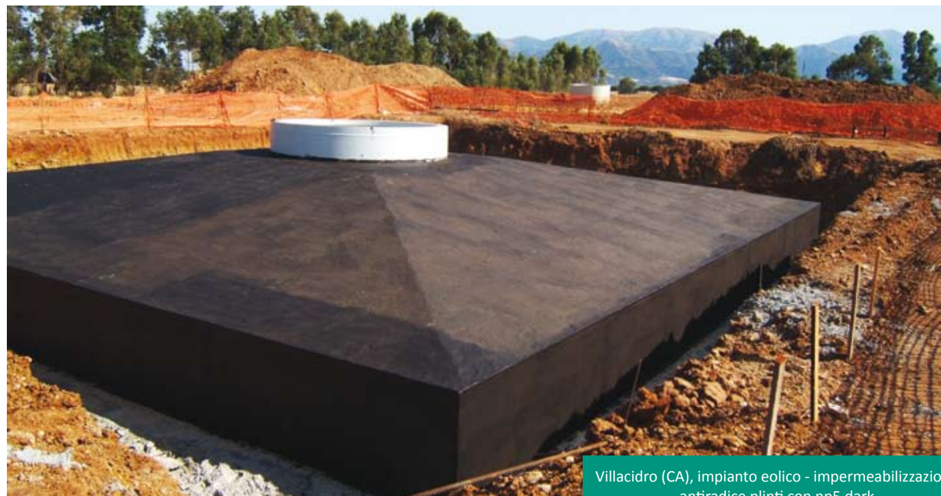
Cagliari, impermeabilizzazione tetto con CEMENGUAINA
