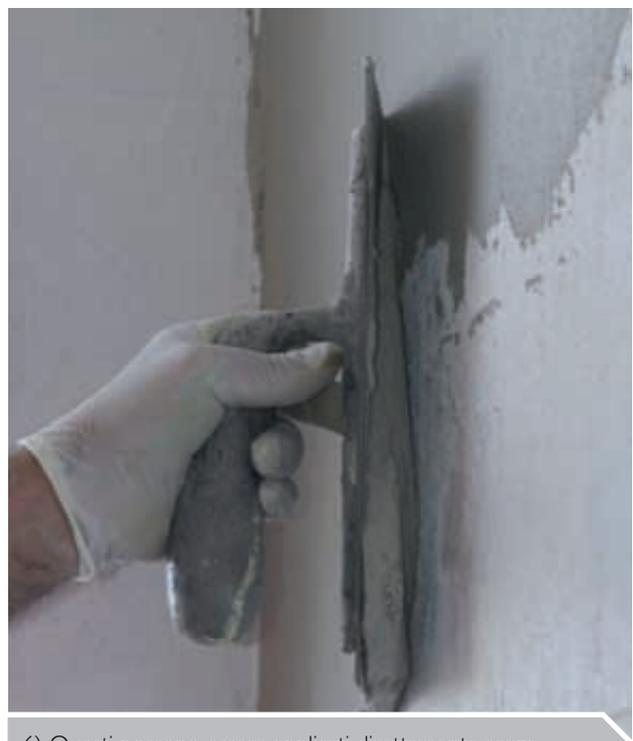
6) Questi possono essere applicati direttamente senza particolari indicazioni, con la possibilità di realizzare alti rivestimenti (fino a 2 cm di spessore) oppure rasature, nel caso specifico utilizzando Nai Cm Rasante Ultra.
