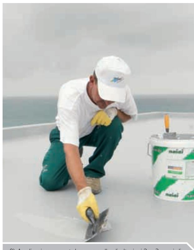
8) Applicazione a spatola o pennello di ulteriori 2 o 3 mani di Fibroguaina-S a mani incrociate per un consumo medio non inferiore ai 2 kg/mq.
