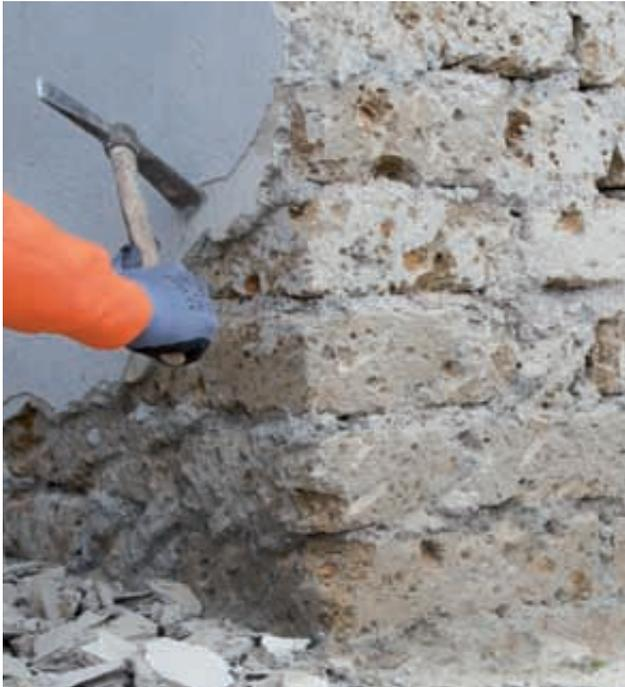
1) Prima di iniziare l'applicazione del Salvamuro Gel è necessario rimuovere l'intonaco per almeno 1 mt. oltre la zona ammalorata.
