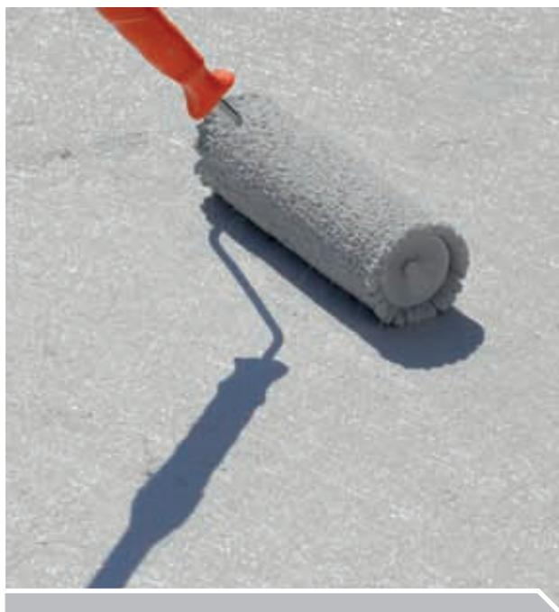
8) Terminata la posa dell'armatura sia sui verticali che sulla superficie orizzontale, si lascia asciugare. Il giorno dopo si può iniziare l'applicazione delle mani successive partendo sempre dai verticali. Ripetere le operazioni di ripasso fino a chiusura della fibra di vetro (ca. 2-2,5 kg/mq, non superando il consumo medio di ca 500gr/mq per ogni mano).
