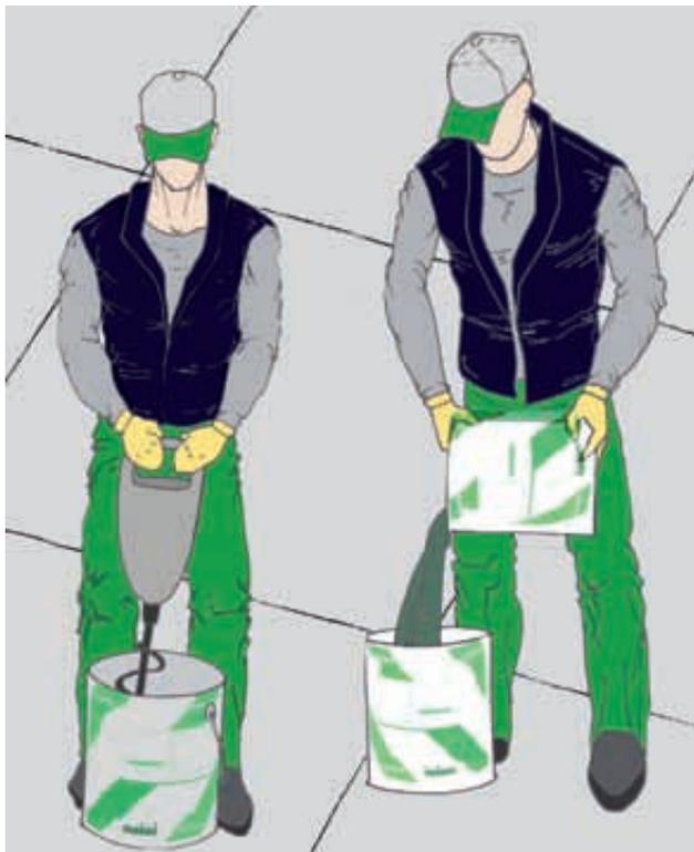
3) Versare il componente B di Nairetan Malta Autolivellante nel componente A e mescolare con miscelatore a basso numero di giri munito di apposita girante.
