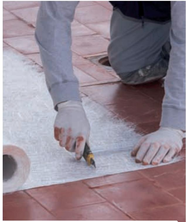
2) Preparazione della fibra di vetro tagliata a misura per impermeabilizzare i verticali della superficie ed eventuali bocchettoni di scarico.
