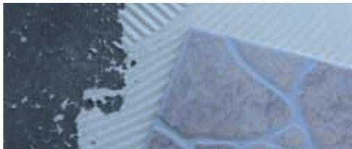
Dopo circa sette giorni dall'applicazione di CEMENGUAINA, si può scegliere di applicare una nuova pavimentazione mediante l'uso del collante per esterni NAI CM KOLFLEX (categoria C2TES1).
