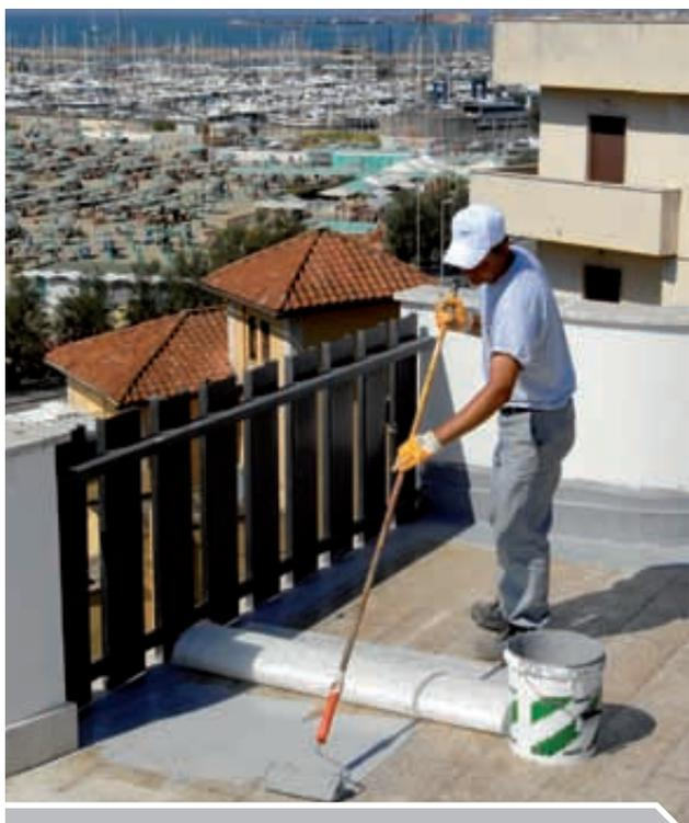
7) Dopo 15'-30' dall'applicazione di Nai 45, stendere sulla superficie orizzontale una mano di Np7 sovrapponendovi subito, a fresco, la fibra di vetro. Rivestire quindi a fresco la fibra con ulteriore Np7.
