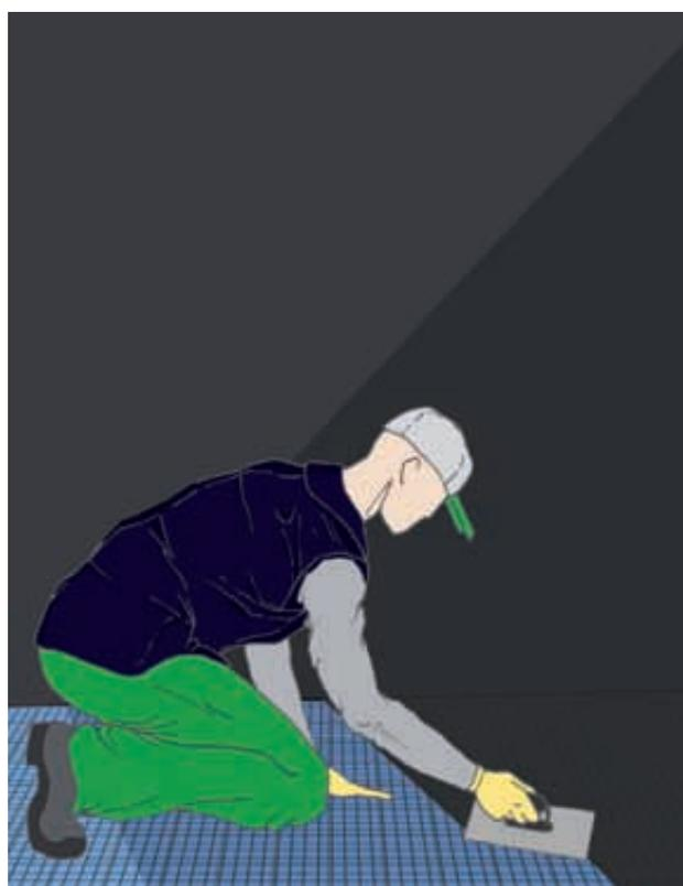
4) Applicazione della rete FV 70 sul pavimento con Igotran Fino.
