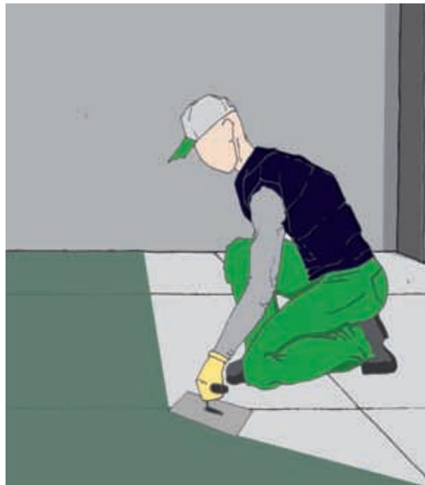
4) Applicare in un'unica mano il Nairetan Malta Autolivellante, utilizzando una spatola dentata, per un consumo medio di ca 3 kg/mq. Passare sul prodotto fresco il rullo frangibolle (indossando scarpe chiodate) per evitare la formazione di bolle d'aria.
