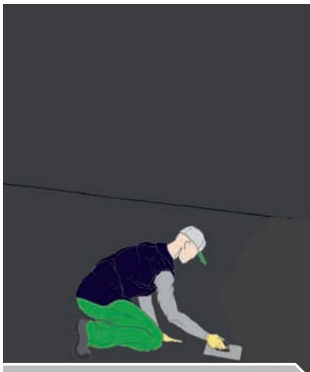
5) Applicazione delle successive mani di Igrotan Fino sia parete che pavimento per un consumo finale di almeno 900 gr/mq (circa 300 gr/mq per mano) fino ad ottenere una superficie perfettamente lucida.
