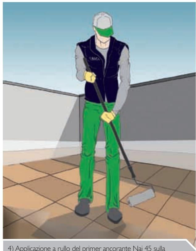
4) Applicazione a rullo del primer ancorante Nai 45 sulla superficie da impermeabilizzare (attendere l'asciugatura, circa 30' min in funzione della temperatura esterna).
