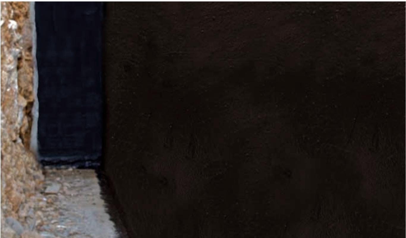
6) La parete dopo l'intervento con Fibrodark pronta per essere "interrata". Attendere la completa asciugatura di Fibrodark (6 giorni a temperatura di 20°C - vedere scheda tecnica) prima di reinterrare.
