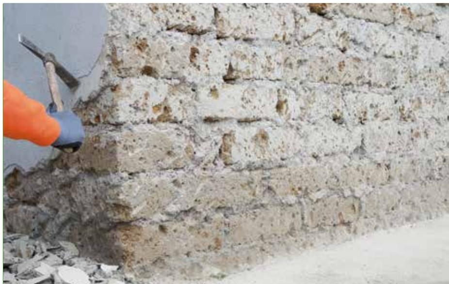
Una volta stabilita la quota dove eseguire i fori (per un'altezza di 12 cm dalla quota del pavimento), si inizia a realizzare il primo foro a 6 cm dall'angolo e poi si continua ogni 12 cm.
