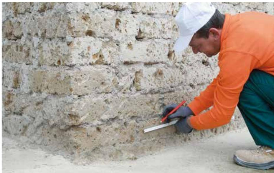
Nel caso si debba intervenire dall'esterno si deve stabilire il livello di perforazione tenendo conto delle quote del pavimento, ovvero la foratura del muro deve avvenire ca. 12 cm sopra la linea del pavimento interno.
