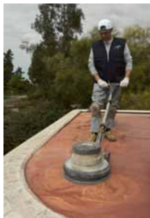
2) Carteggiatura accurata di tutta la superficie e pulizia del materiale di risulta.
