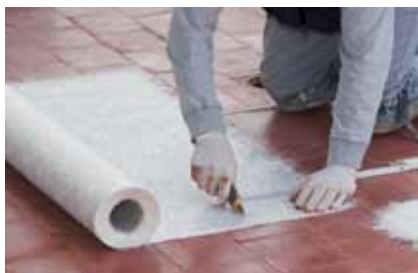
3) Preparazione della fibra di vetro tagliata a misura per impermeabilizzare i verticali della superficie ed eventuali bocchettoni di scarico.
