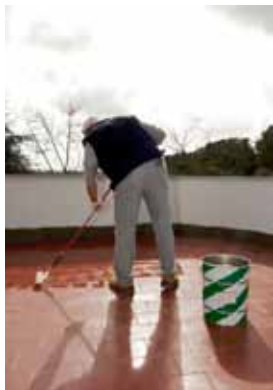
8) Stesura del primer ancorante NAI 45 sulla superficie orizzontale.
