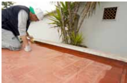
4) Applicazione nei verticali di primer ancorante NAI 45.
