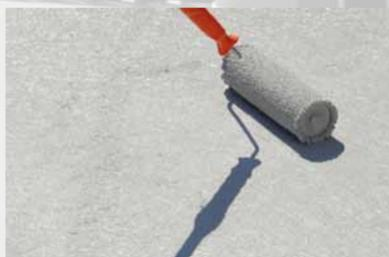
9) Terminata la posa dell'armatura sia sui verticali che sulla superficie orizzontale, si lascia asciugare. Il giorno dopo si può iniziare l'applicazione delle mani successive partendo sempre dai verticali. Ripetere le operazioni di ripasso fino a chiusura della fibra di vetro (ca. 2-2,5 kg/mq, non superando il consumo medio di ca 500gr./mq per ogni mano).
