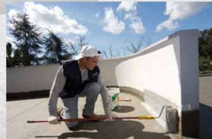
Terminata la posa dell'armatura, sia sui verticali che sulla superficie orizzontale, si lascia asciugare. Il giorno dopo si può iniziare l'applicazione delle mani successive partendo sempre dai verticali.
