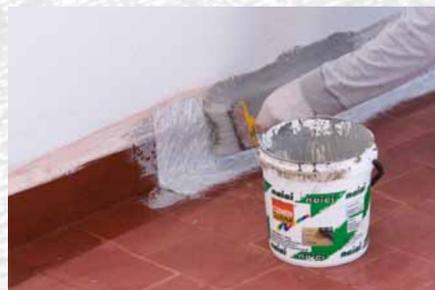
Dopo l'applicazione del NAI 45 o NAI 45H, stendere sui verticali una mano di Cemenguaina sovrapponendovi subito, a fresco, la fibra di vetro. Rivestire, quindi, la fibra con ulteriore CEMENGUAINA.
