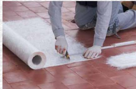
Preparazione della fibra di vetro tagliata a misura per impermeabilizzare i verticali della superficie ed eventuali bocchettoni di scarico.
