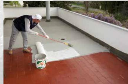
Dopo l'applicazione del NAI 45 o NAI 45H, stendere sulla superficie orizzontale una mano di Cemenguaina sovrapponendovi subito, a fresco, la fibra di vetro. Rivestire, quindi, la fibra con ulteriore CEMENGUAINA.
