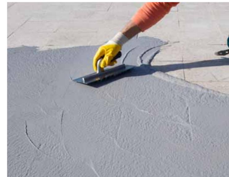
Buon pomeriggio, in merito alla sua richiesta, comunichiamo che al fine di impermeabilizzare la superficie da lei descritta, è necessario realizzare sulla stessa un massetto cementizio su strato di scorrimento in polietilene da 300 gr/mq, avendo cura di rivoltarlo su tutte le strutture in elevazione e previa applicazione di una bandella comprimibile in poliuretano estruso espanso.
