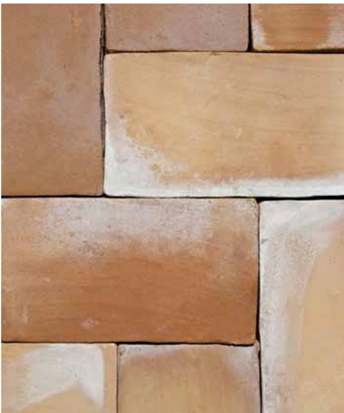
Il fenomeno si chiama salinizzazione riguarda la presenza dei Sali (nitrato di potassio) contenuti nel supporto, l'umidità ascendente bagna il supporto ed in fase di evaporazione, trasporta i sali depositandoli in superficie. La soluzione sta nell'eseguire un lavaggio acido tale da rimuovere il salnitro e, ad asciugatura avvenuta, può essere bloccato con un idoneo prodotto chiamato STOPPER da applicare più volte rispettando le indicazioni riportate nella relativa scheda tecnica.
