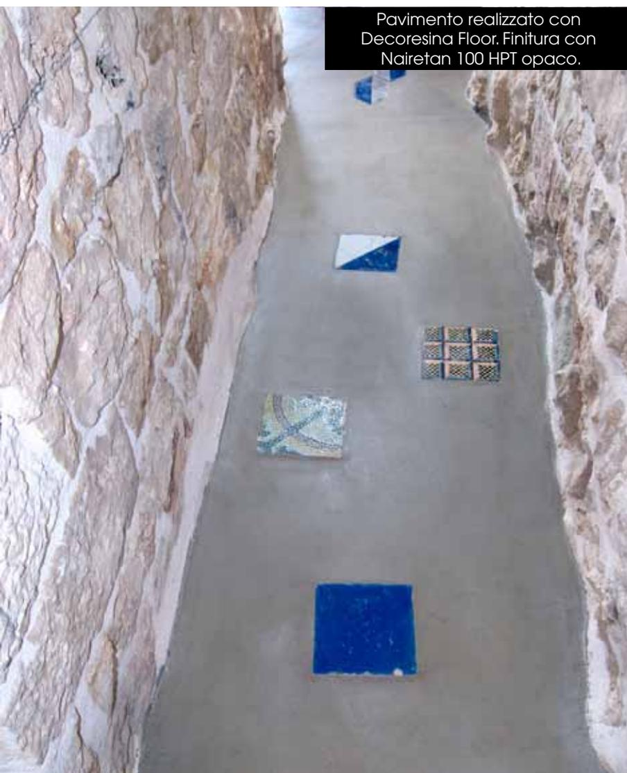
Pavimento realizzato con Decoresina Floor. Finitura con Nairetan 100 HPT opaco.
