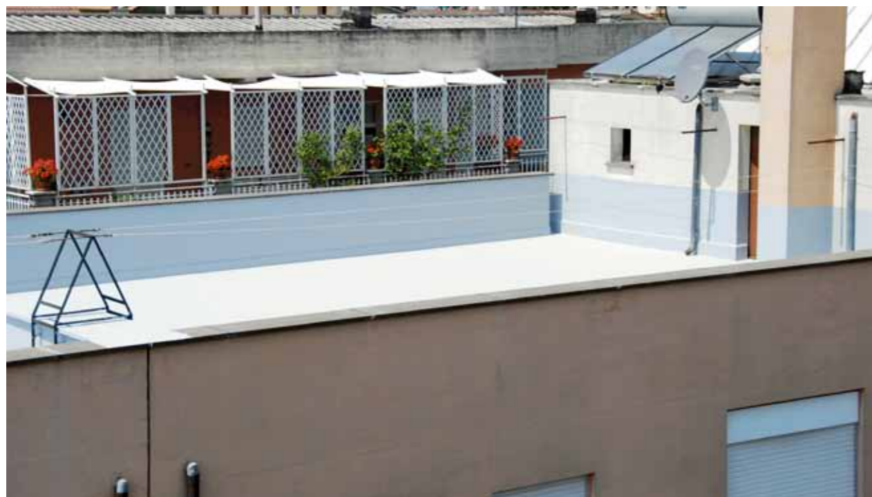
Impermeabilizzazione eseguita con NP7 – Vallerano (VT)
