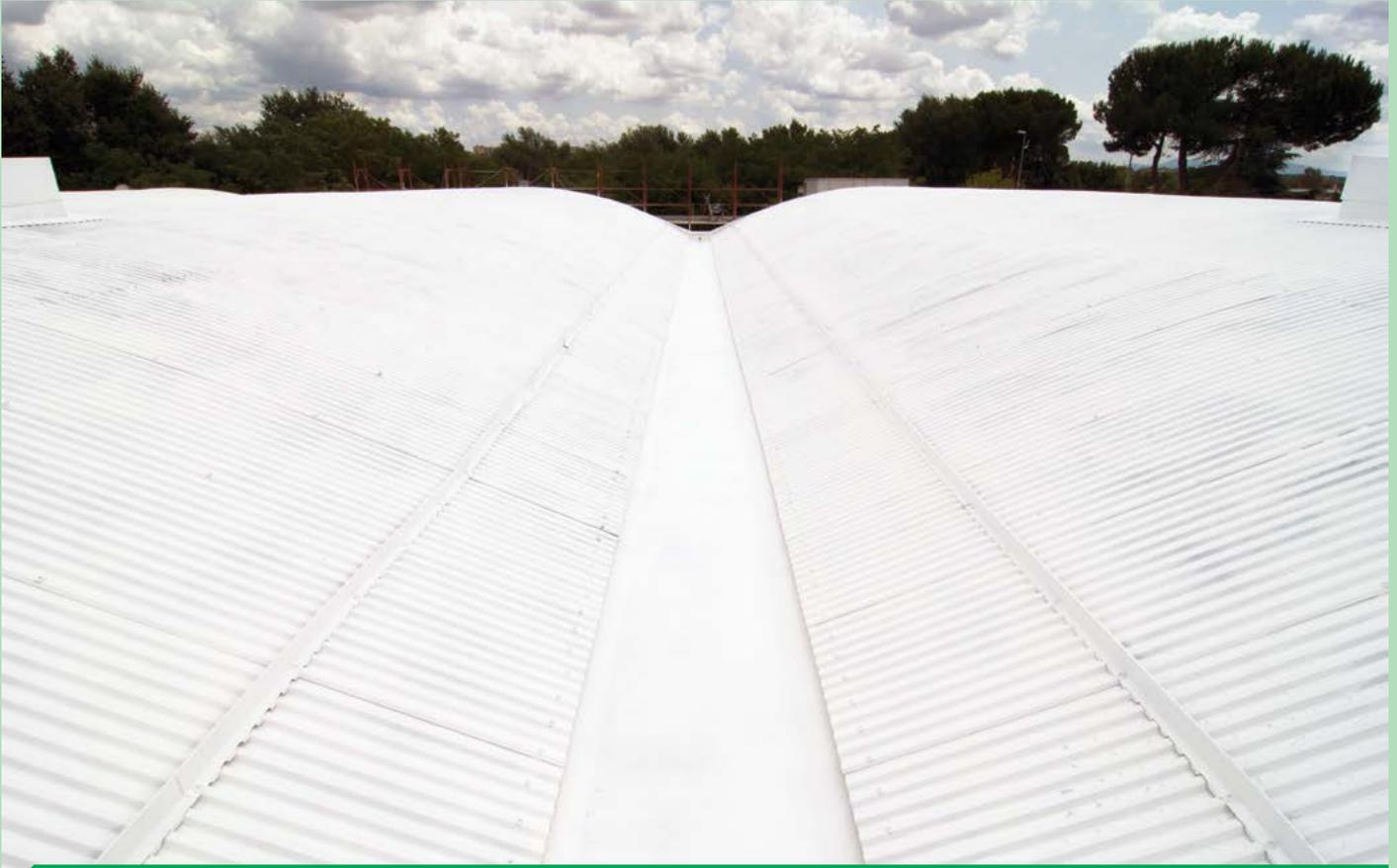
Impermeabilizzazione di un tetto industriale mediante l'utilizzo di NP 7 Naici applicato ad airless.
