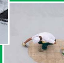
FIBROGUAINA (a rullo) & FIBROGUAINA-S (a spatola): Guaina liquida monocomponente antiristagno di facile applicazione, su qualsiasi superficie, per l'impermeabilizzazione definitiva di balconi, terrazzi, coperture e docce.
