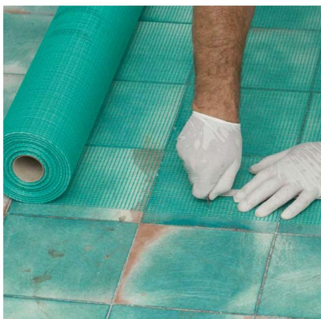
4) Preparazione del supporto mediante armatura RETE DIVETRO FV 160
