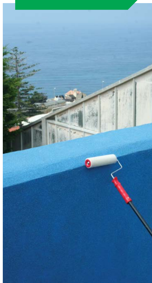
Applicazione della seconda mano del Primer.
