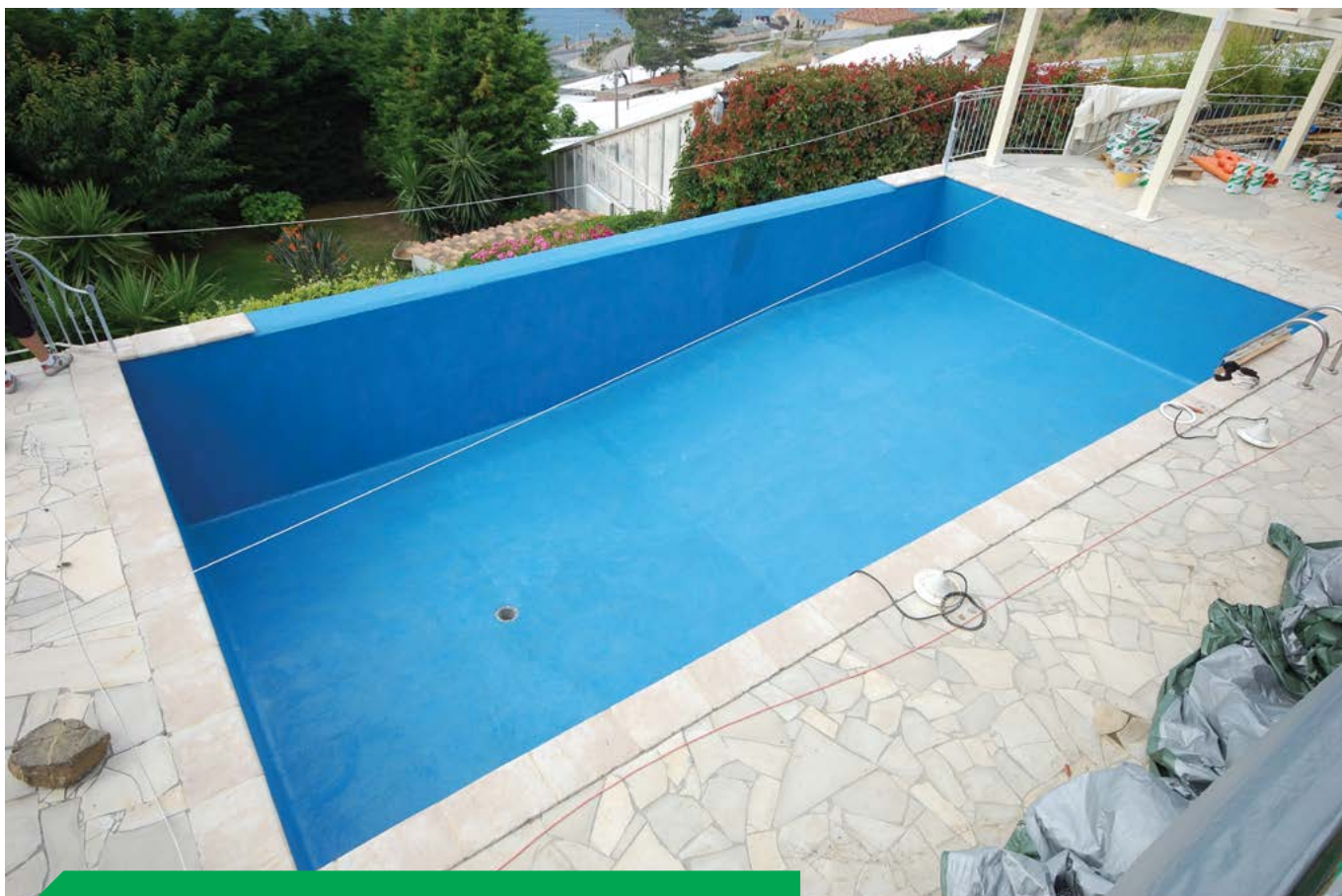
Panoramica della piscina con sistema ceramic pool ultimato.
