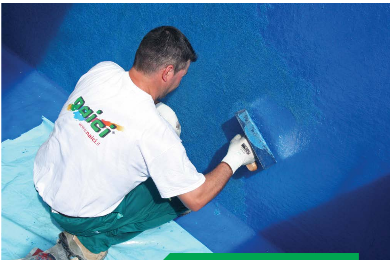
Applicazione del Ceramic Pool sulla parete verticale
