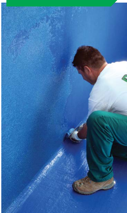
Applicazione del prodotto sul raccordo tra superficie orizzontale e superficie verticale
