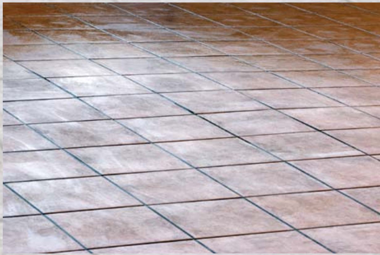
Terminata l'applicazione di Salvatore Trasparente 2° mano su tutto il terrazzo attendere ca. 30 min. e se necessario rimuovere il prodotto in eccesso con uno straccio asciutto.
