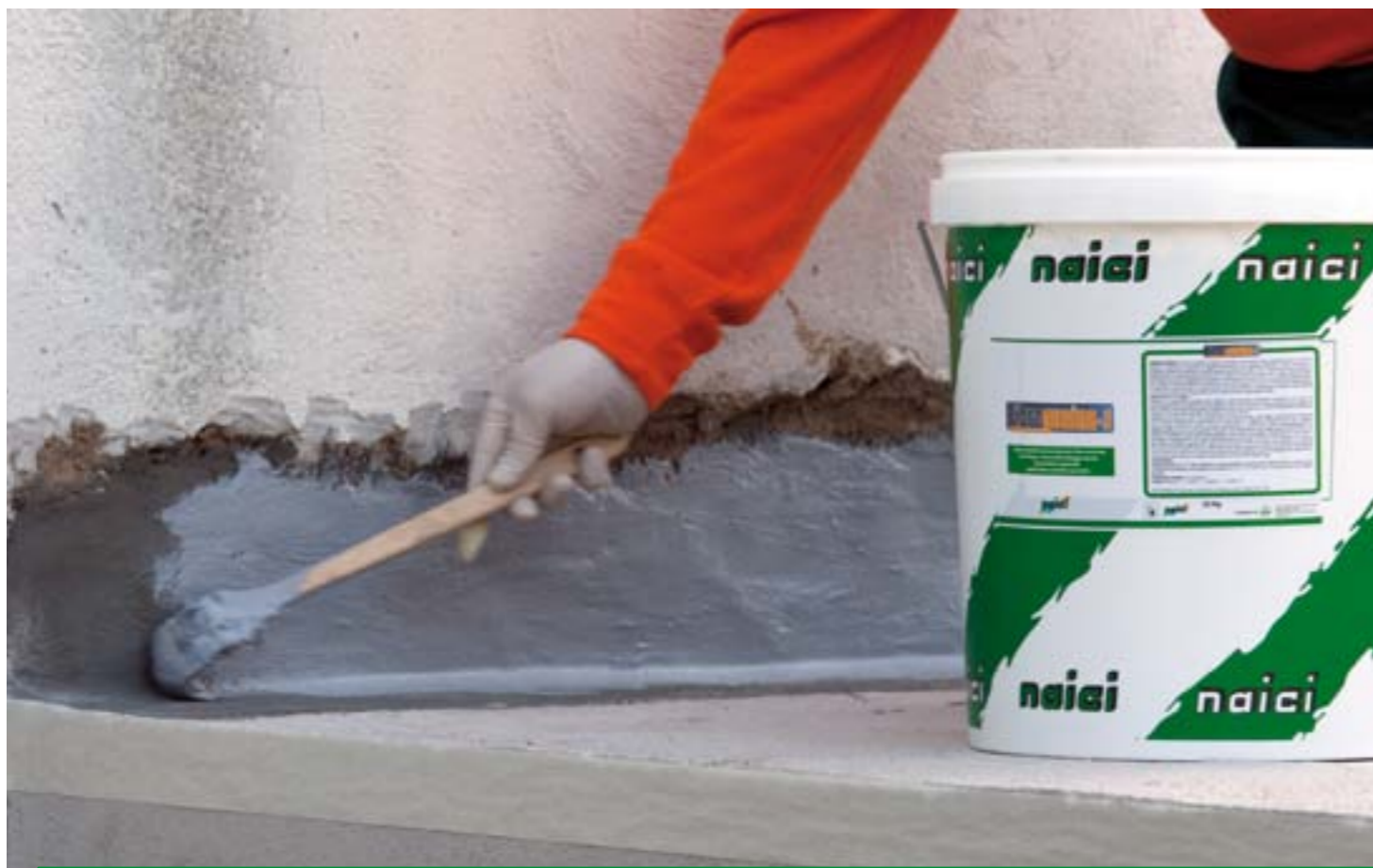
Applicazione della FIBROGUAINA-S sui verticali
