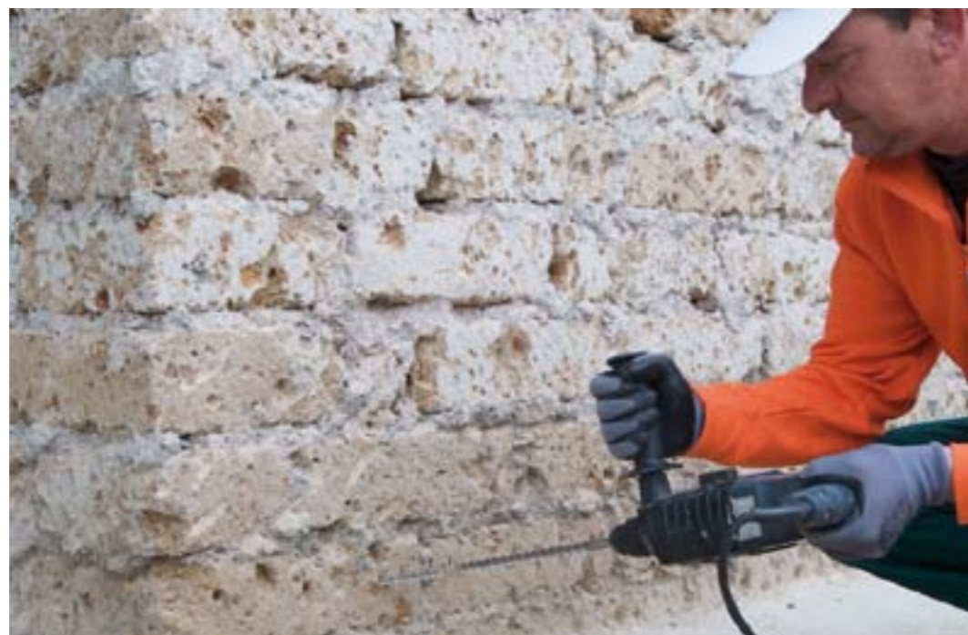
Realizzazione dei fori
