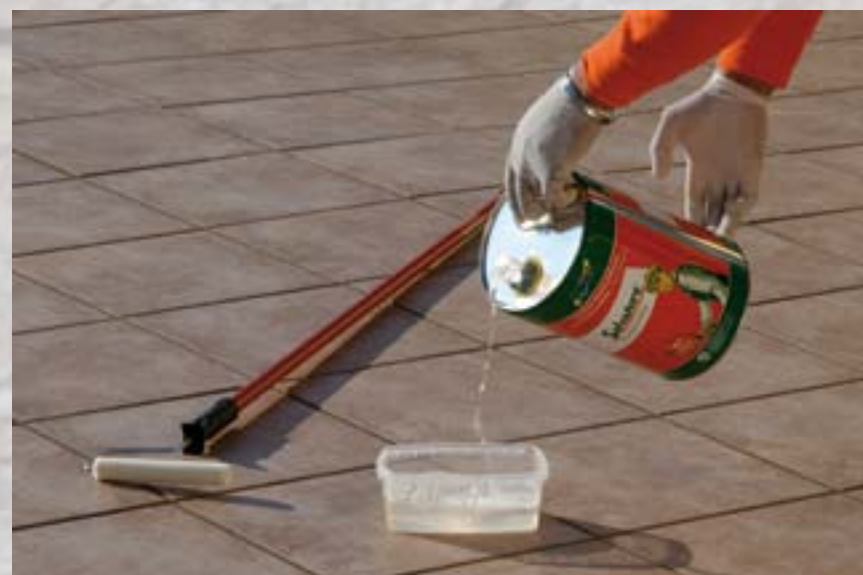
Versare Salvatore Trasparente 1° mano nel contenitore
