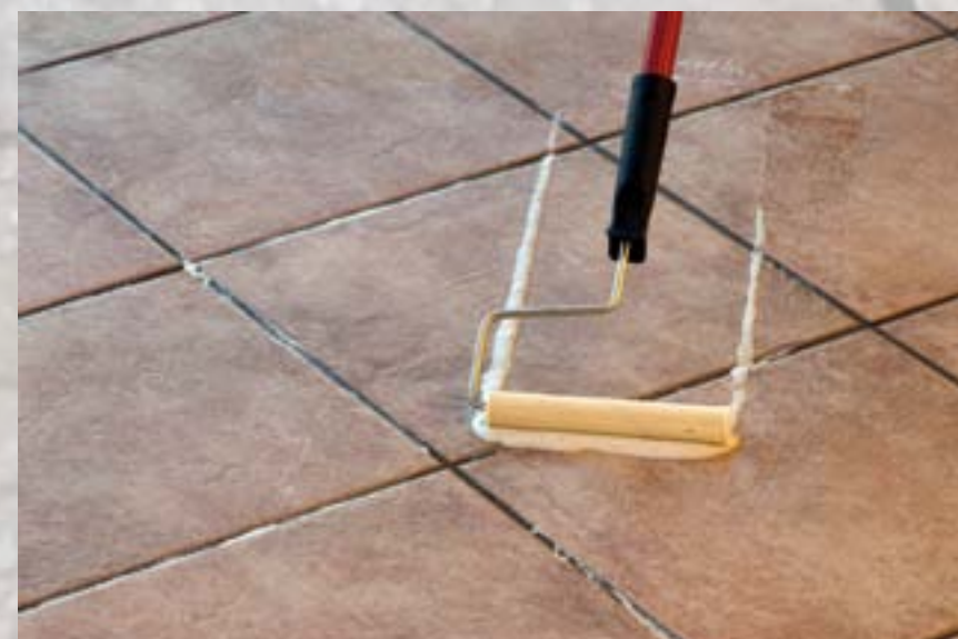
Soffermandosi anche in questo caso maggiormente nelle fughe dei mattoni.
