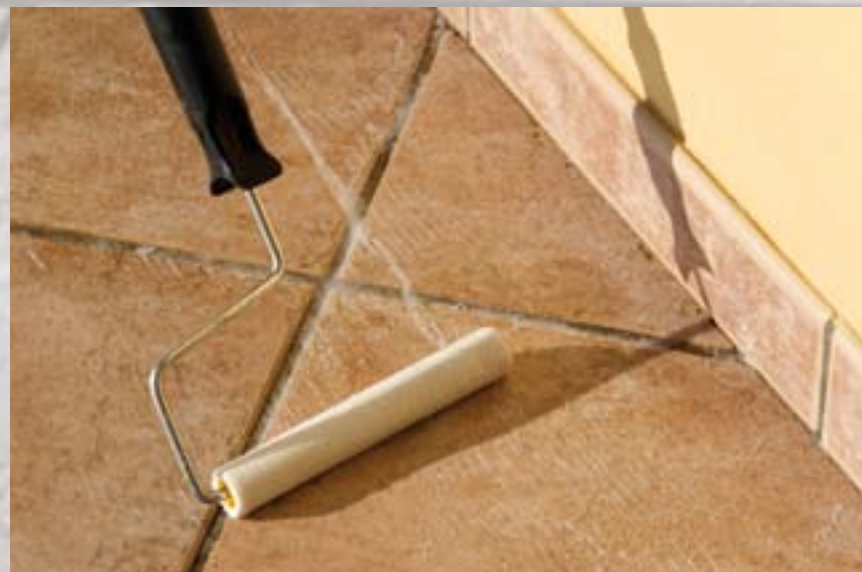
Avendo cura di farlo penetrare bene nelle fughe dei mattoni.
