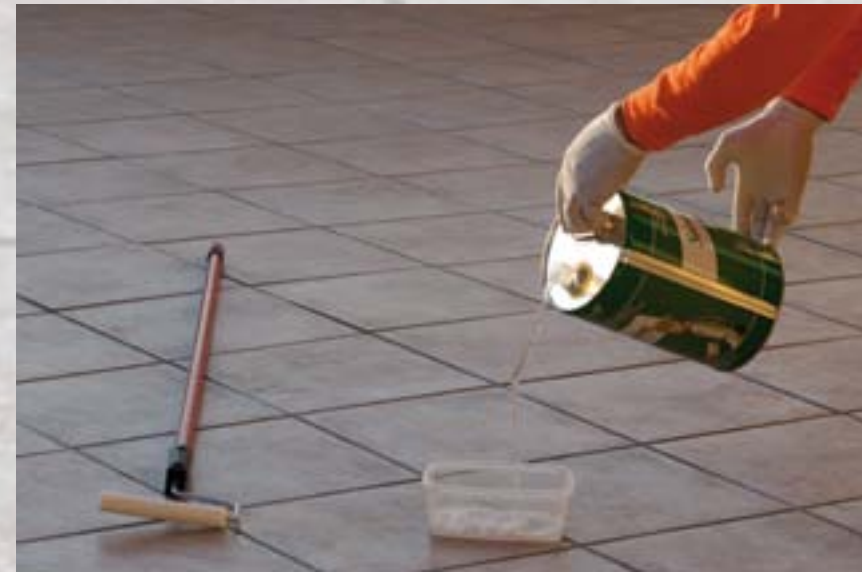
Versare Salvatore Trasparente 2° mano nel contenitore
