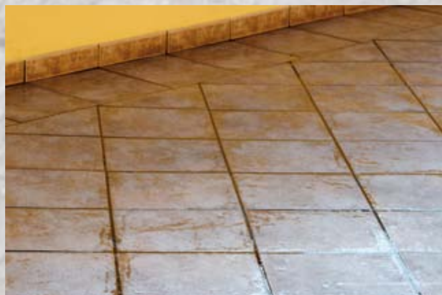
Terminata l'applicazione di Salvatore Trasparente 1° mano su tutto il terrazzo attendere l'asciugatura. (ca. 60 minuti a 20°C)
