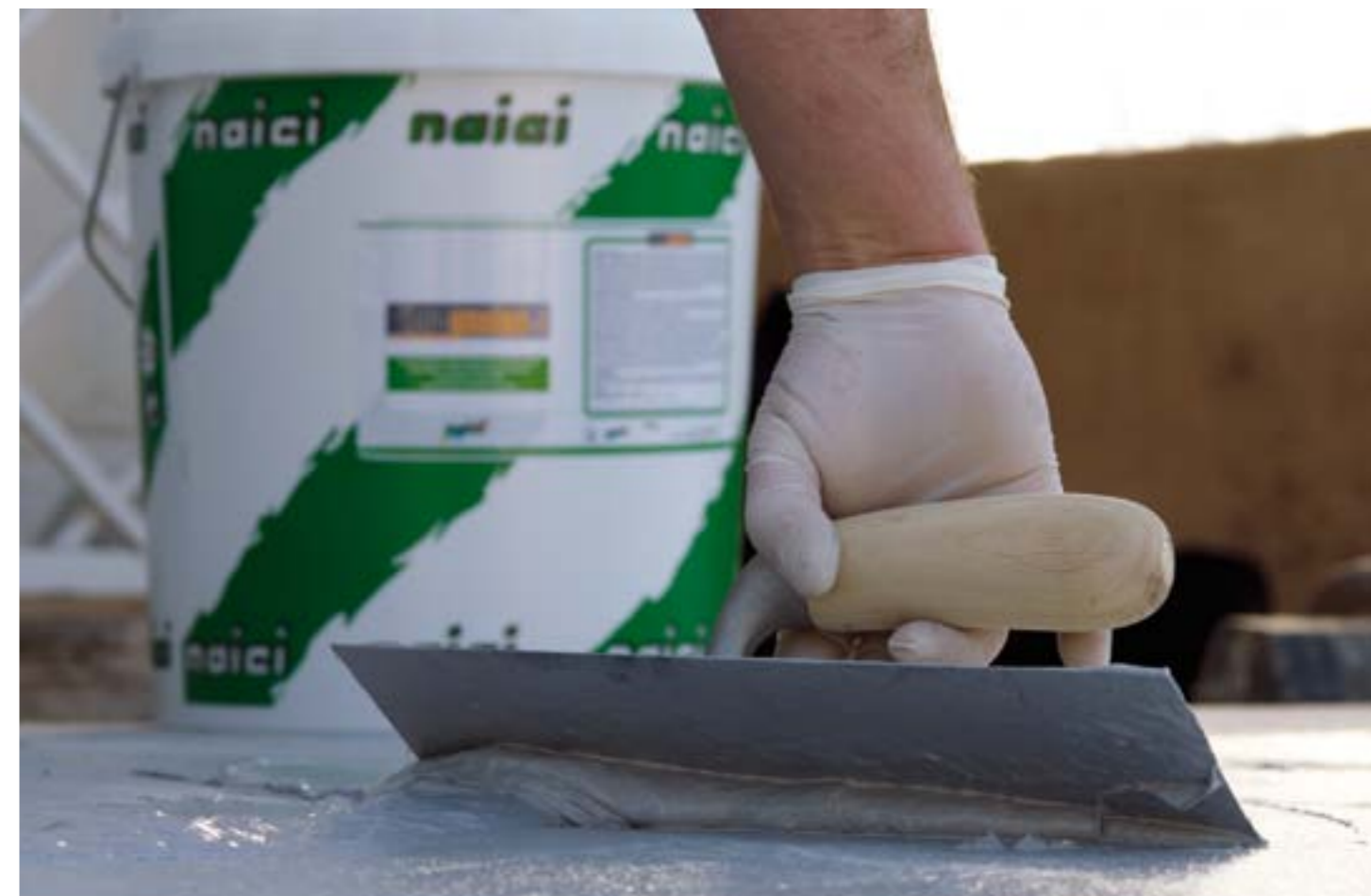
Nelle foto applicazioni della FIBROGUAINA-S su pavimento
