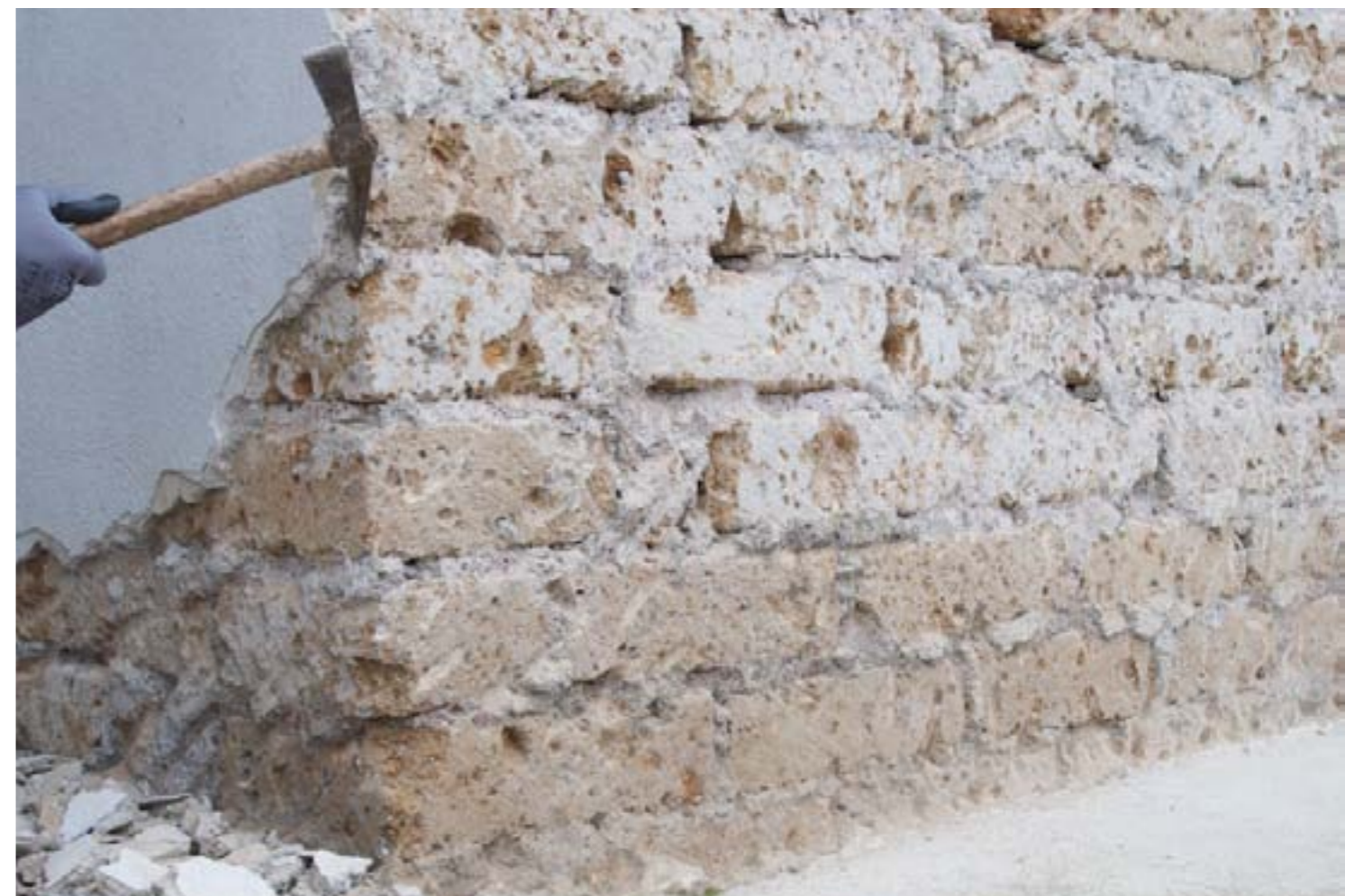
Rimozione dell'intonaco esistente
