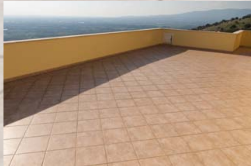
Terrazzo con problemi di infiltrazioni
