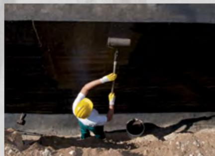
8. Completamento dell'operazione con ulteriori mani di NP5 DARK fino a chiusura della fibra di vetro (ca. 3 kg/mq non superando il consumo di 400-500 gr/mq per mano).
