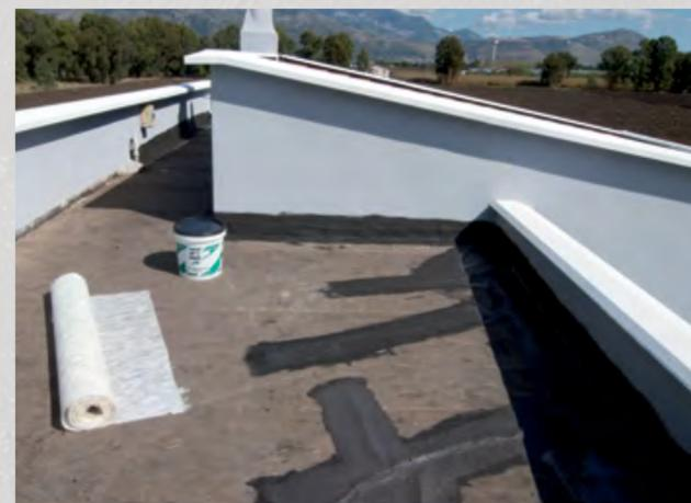
4. Terminata la posa dell'armatura si lascia asciugare; il giorno dopo si procede con l'applicazione delle mani successive. Si ripete l'operazione di ripasso fino a completa chiusura della fibra di vetro (ca. 2 kg/mq non superando il consumo di 500gr/mq per mano).
