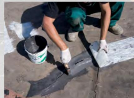
3. Dopo aver pulito la superficie si applica una mano di NP5 DARK. Quando il prodotto è ancora fresco si posiziona la fibra di vetro (mat 225 naici) e "fresco su fresco" si applica un'ulteriore mano di NP5 DARK ad impregnazione della fibra.
