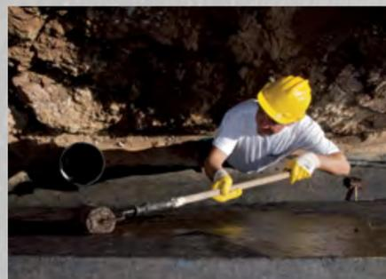
7. Al termine della posa della fibra di vetro, e ad asciugatura avvenuta, applicazione delle ulteriori mani di NP5 DARK.
